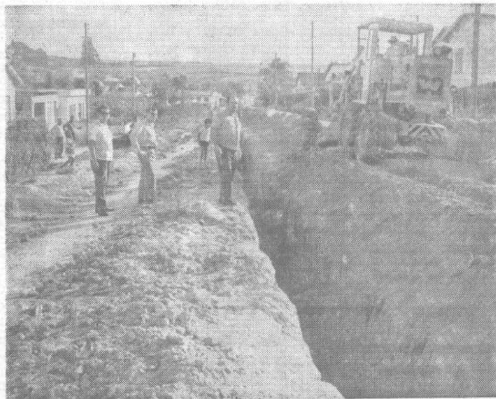
O sr. Prefeito Municipal e seus principais assessores presenciam a moto-niveladora proceder à cobertura das valetas já com as respectivas redes de esgoto. Essa rua, da Vila Brasil, é a Rua Pernambuco que agora se nivela às outras barbarenses, com toda a infra-estrutura.
