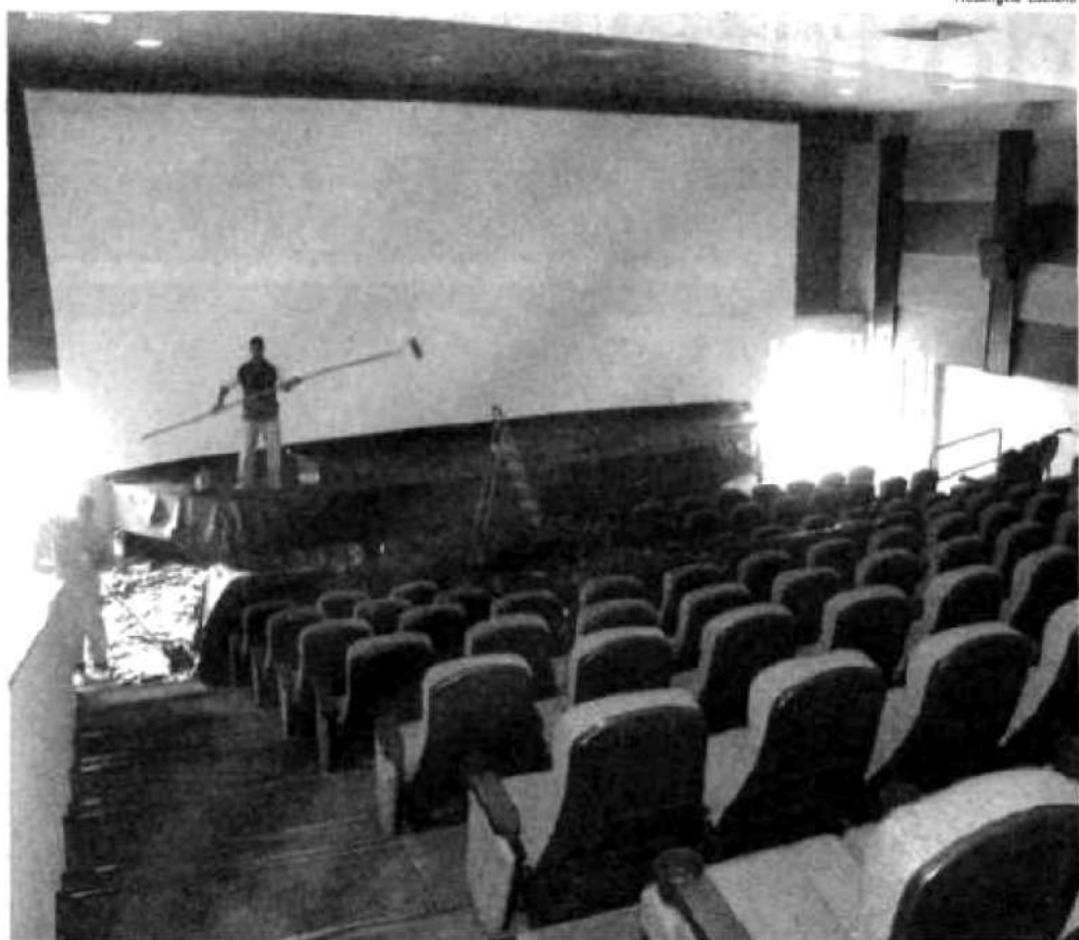
Reforma no Moviecom está sendo concluída
